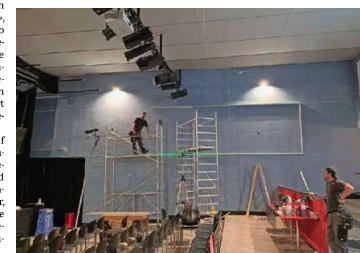
Optimierungen für den Betrieb: Hier werden Schallschutzpanels angebracht. Christoph Wildhaber (kleines Bild rechts) war der erste Präsident der Kulturvereinigung.
